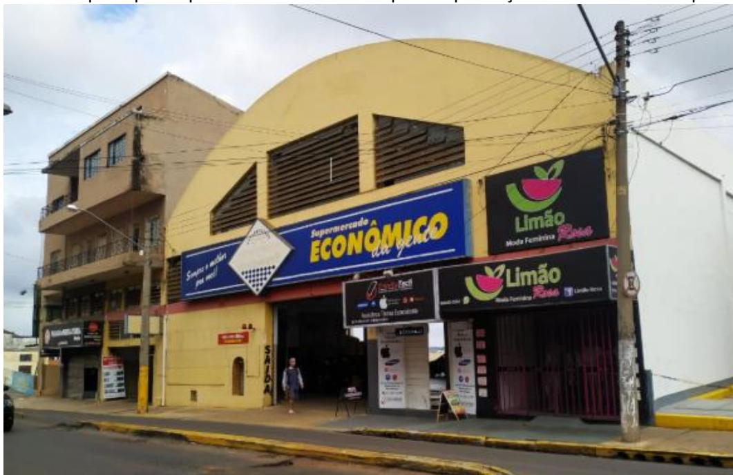
Figura 11. Fachada principal da pré-existência escolhida para implantação do Restaurante Popular.
