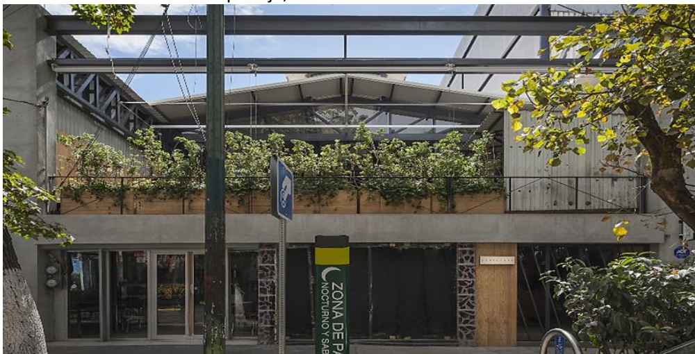
Figura 1. Fachada do Restaurante Campobaja, na Cidade do México.
