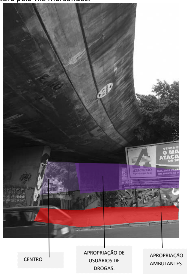
Figura 5. Vista da estrutura pela vila Marcondes.
