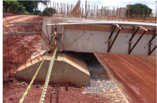
Figura 14. Detalhe do apoio de um viaduto portante executado em Maringá-PR.
