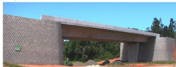
Figura 6. Face de bloco segmentados, construção de um acesso transversal à rodovia Federal BR 101, no Rio Grande do Sul.
