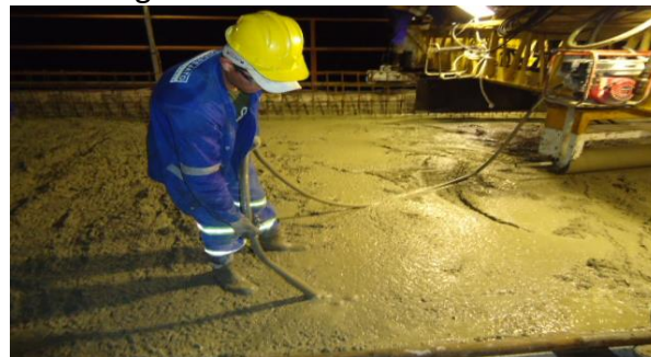
Figura 10. Uso de vibradores na concretagem.
