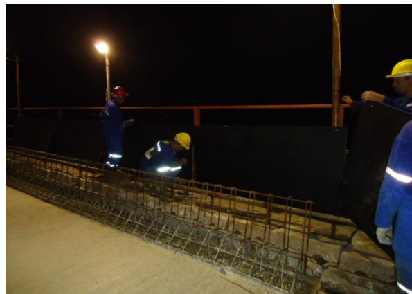
Figura 11. Tapumes para contenção de vento lateral.
