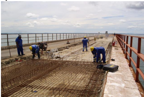
Figura 08. Execução da fixação das telas de aço.
