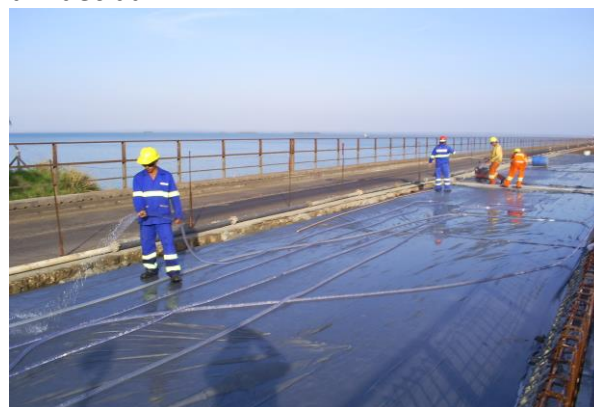
Figura 16. Execução da cura úmida pavimento de concreto com manta geotêxtil umidecida.
