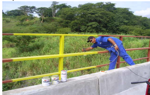
Figura 29. Execução do guarda-corpo original da ponte.
