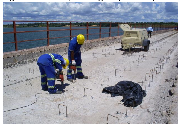
Figura 07. Execução dos grampos de aço.
