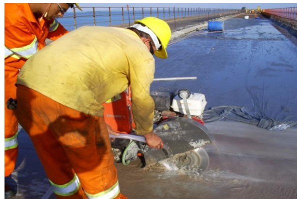
Figura 15. Serragem das juntas de dilatação intermediárias.
