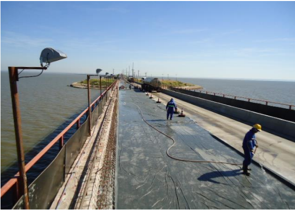
Figura 17. Execução da cura úmida do pavimento de concreto com manta geotêxtil.
