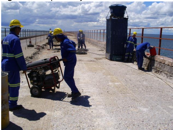
Figura 06. Topo da laje do tabuleiro fresado.
