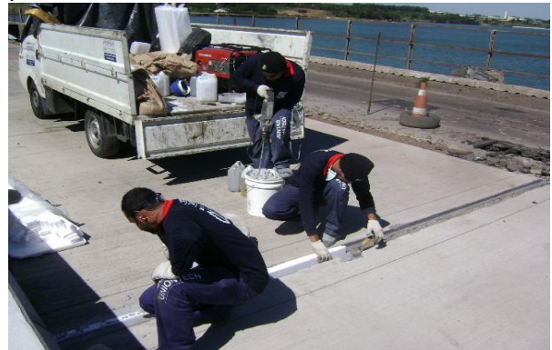
Figura 20. Execução de um dos lábios poliméricos.
