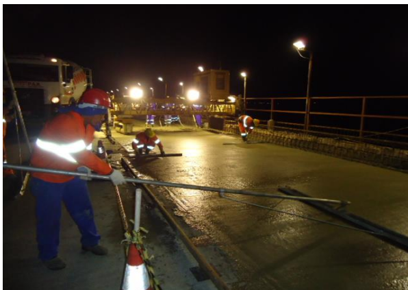
Figura 12. Nivelamento mecânico do pavimento ao fundo com acabamento manual.
